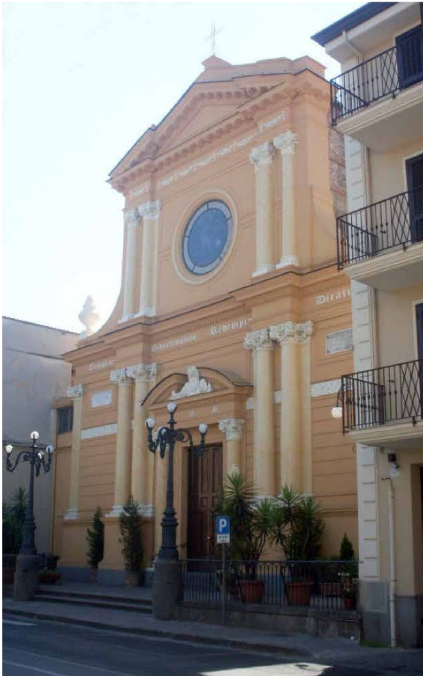
Fig. 4 - Prospetto della chiesa su via C. Pezzullo.
